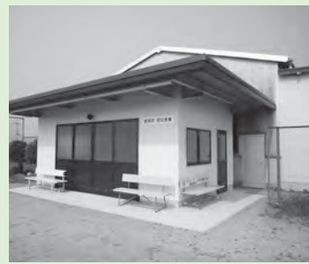
(区の防災倉庫)
