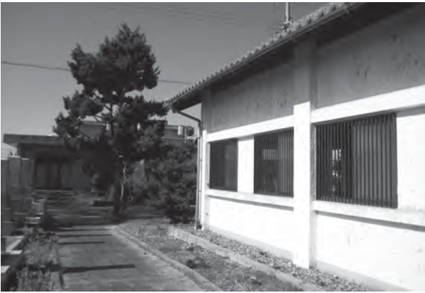
解体予定の町火葬場 還浄殿
