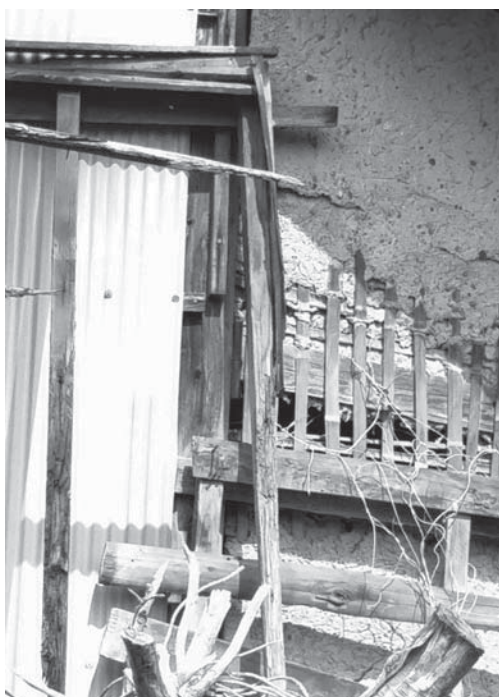
危険な空き家
