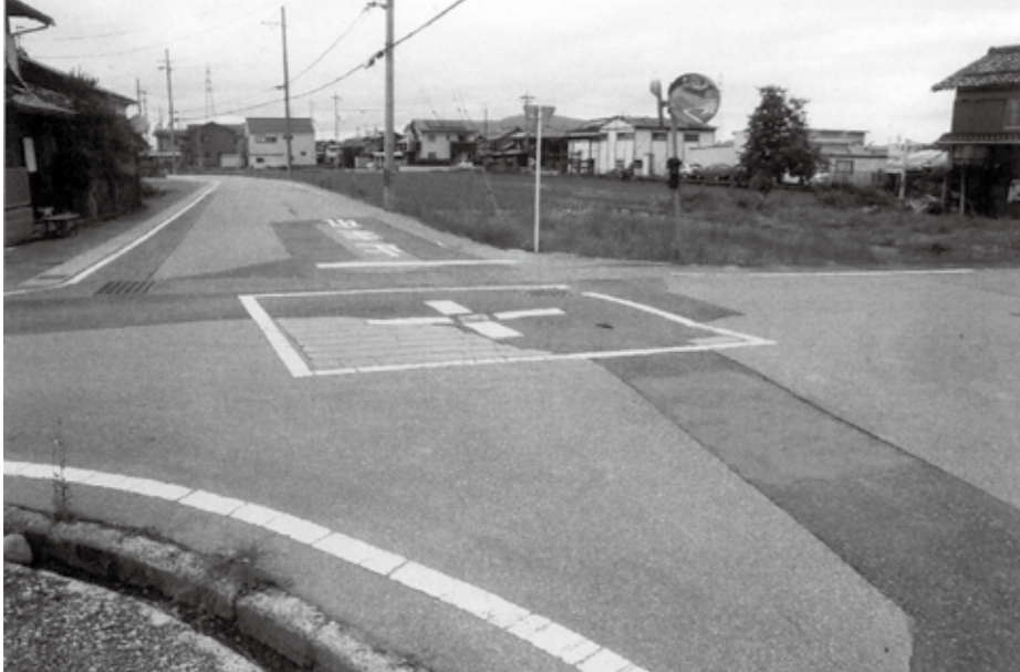
下水道の敷設がえ後の舗装復旧工事予定箇所
