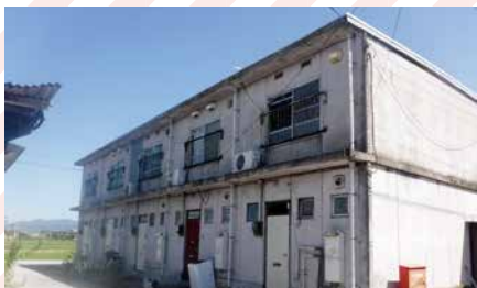
公営住宅ブレーカー改修 7,674千円
