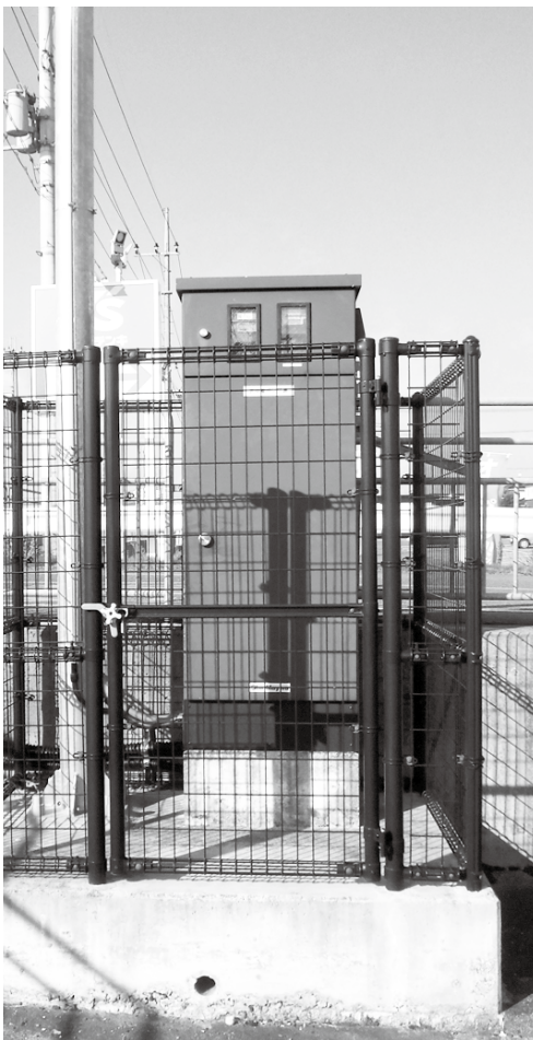
マンホールポンプの制御盤
