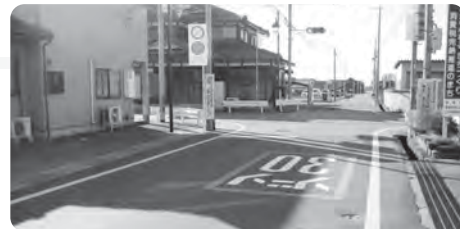
交通安全施設整備
