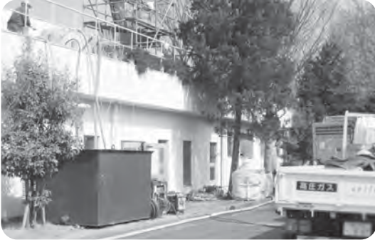
豊楠苑 改修工事中
