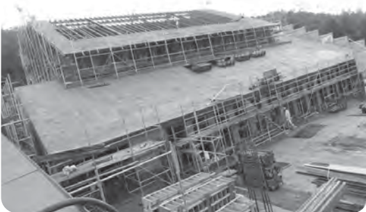
紫雲苑 新築工事中
