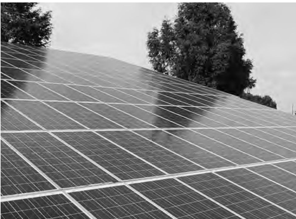
太陽光パネル設置
