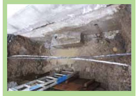
上屋の重量に耐えるだけの寸法がない基礎
