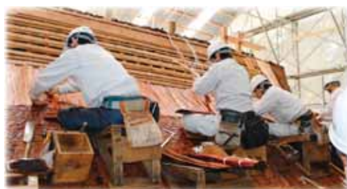
▲檜皮葺施工の様子
