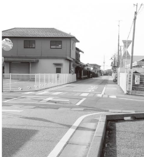
歩道が設置されていない道路
