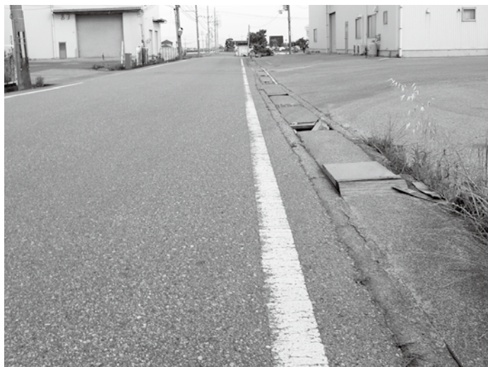
道路改良工事（高野瀬三津線）
