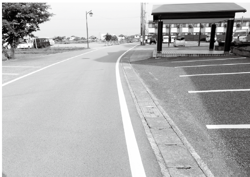
道路改良工事（清崎安食西線）
