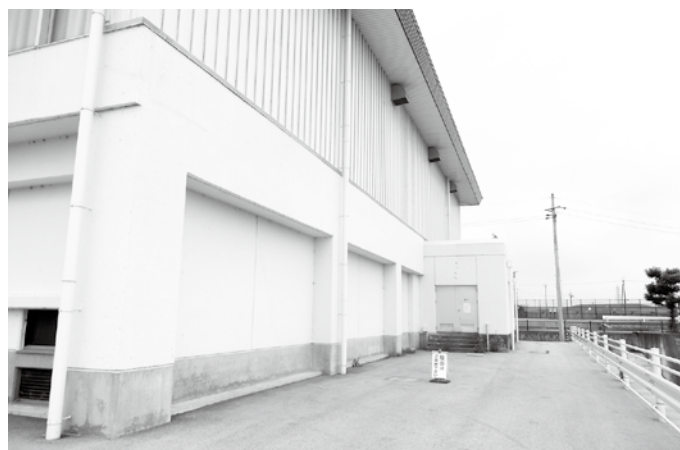
町民体育館裏の死角
