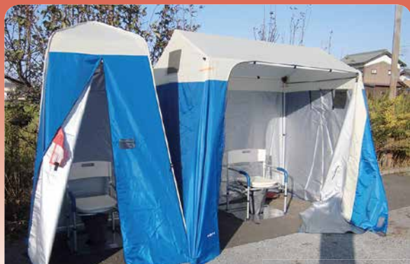
マンホールトイレ
