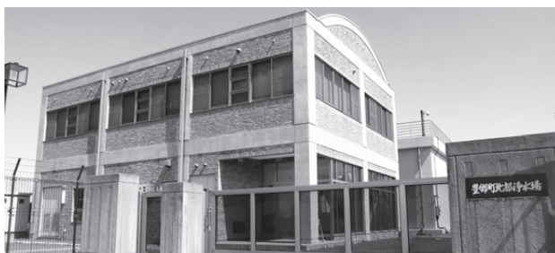
四十九院地先の北部浄水場にある事務所
