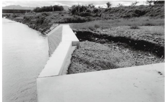
8月14日の大雨で護岸壁裏側部分の土砂が流失してしまった現場
