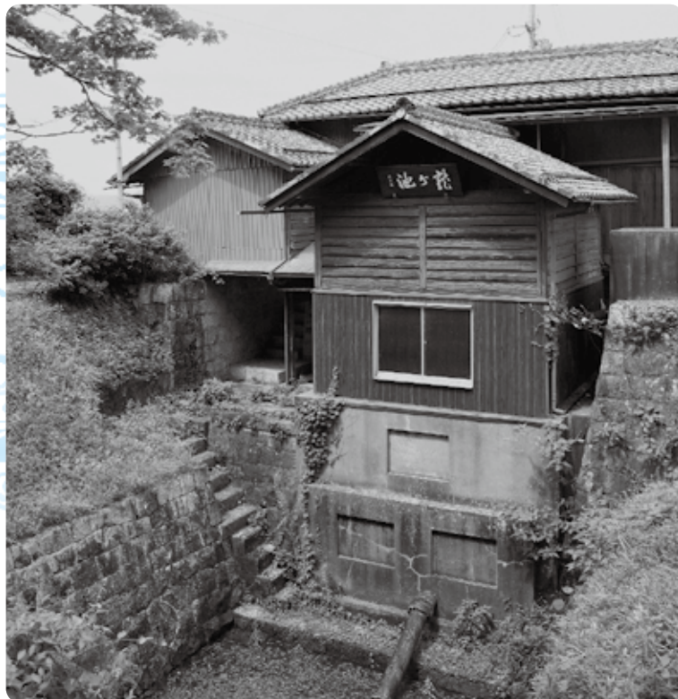
世界かんがい施設遺産の候補となった龍ヶ池揚水機場
