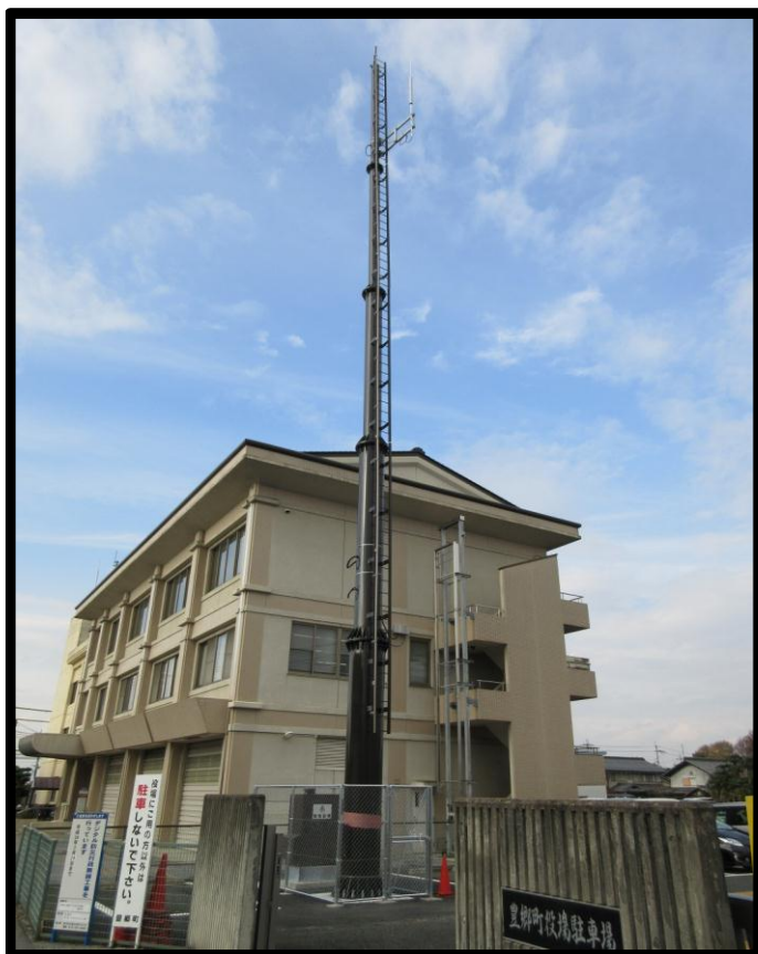
■ 役場別館駐車場に建柱した親局アンテナ
